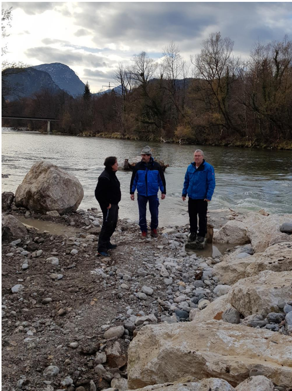
Abb. 2: Zufrieden mit dem Um- bau des Ufers sind (von links) Irmingard De- chant, Flussmeisterin der Flussmeisterstelle Piding und Leiterin des Projekts, Vorarbeiter Christian Singhartinger sowie Stefan Hollrieder vom Wasserwirtschafts- amt Traunstein.
